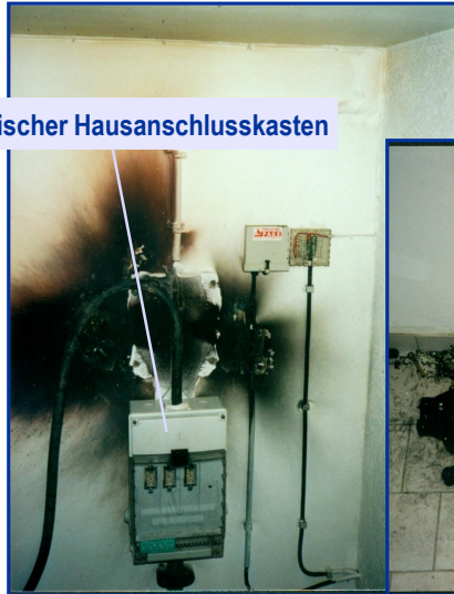
Zerstörter Hausanschlusskasten
